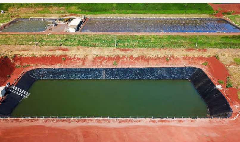
Lagoa de estabilização para tratamento de água em Cafelândia
