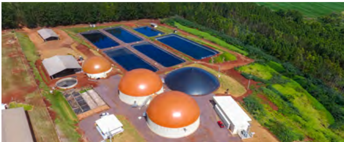
Usina de Biogás em Carajá
